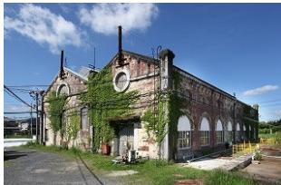
遠賀川水源地ポンプ室
