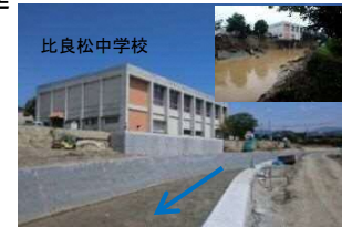
桂川【復旧工事状況】
