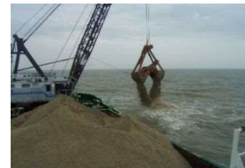
図1 覆砂工事の状況
