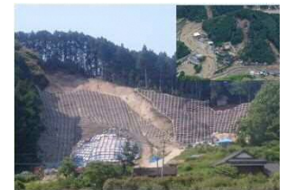
真竹地区急傾斜【復旧工事状況】
