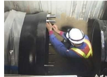
共用水道管の布設
