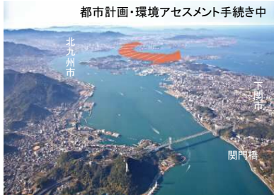
都市計画・環境アセスメント手続き中 関門地域の一体的発展に資する「下関北九州道路」
