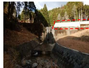
砂防堰堤修繕
