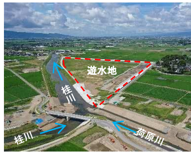
河川整備、遊水地整備
