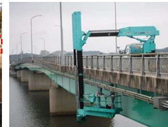
橋梁定期点検
