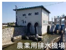
農業用排水機場
