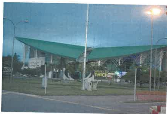
ボルネオ・コンベンション・センター クチン
