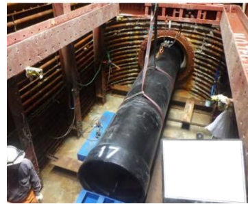
上下水道の一体的な耐震化
