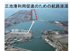
三池港利用促進のための航路浚渫 県南地域の物流拠点 「三池港」
