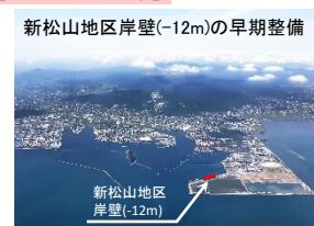
新松山地区岸壁(-12m)の早期整備 自動車産業・セメント産業の 物流拠点「刈田港」
