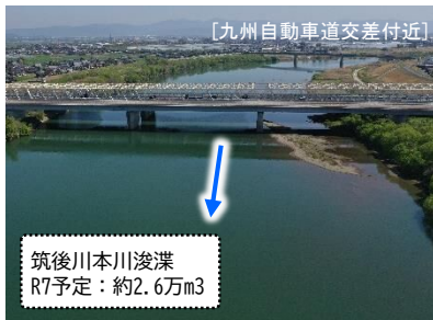
筑後川本川の堆積土砂の浚渫 筑後川本川浚渫 R7予定: 約2.6万m 3
