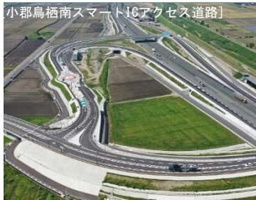
小郡鳥栖南スマートICアクセス道路 救援物資輸送に資する道路整備
