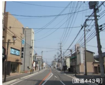
無電柱化(緊急輸送道路) [国道443号]
