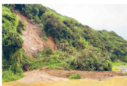
被災した道路
