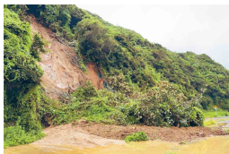
被災した道路
