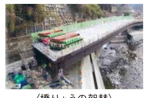
〈橋りょうの架替〉
