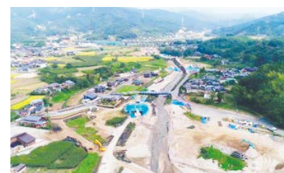
河川の改良工事
