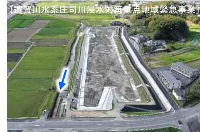
調節池の整備
