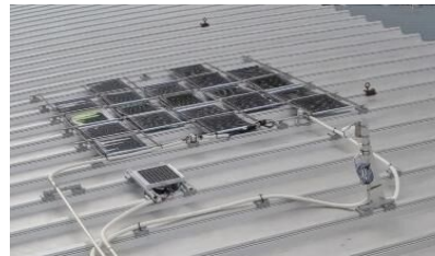
博多駅ホーム屋根
