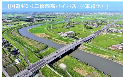
救援物資輸送に資する道路整備
