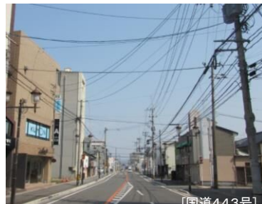
無電柱化(緊急輸送道路)
