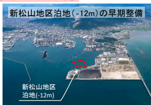
新松山地区泊地(-12m)の早期整備 自動車産業・セメント産業の 物流拠点「刈田港」
