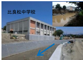
桂川【復旧工事状況】
