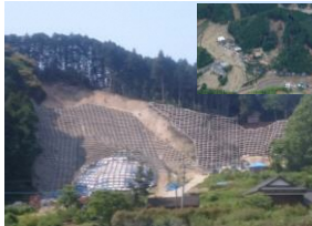
真竹地区急傾斜【復旧工事状況】
