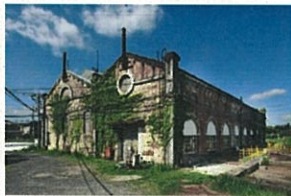
八幡製鉄所遠賀川水源地ポンプ室
