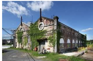
遠賀川水源地ポンプ室
