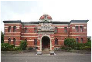
官営八幡製鐵所旧本事務所
