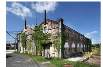
遠賀川水源地ポンプ室
