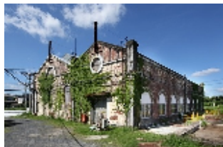
八幡製鉄所遠賀川水源地ポンプ室
