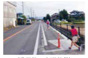
〈通学路の歩道整備〉
