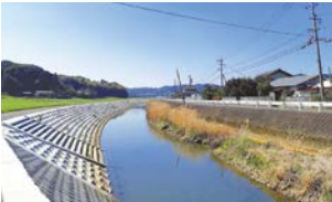
河川の護岸工事
