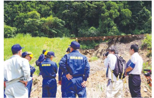
平成筑豊鉄道の被災現場の視察
