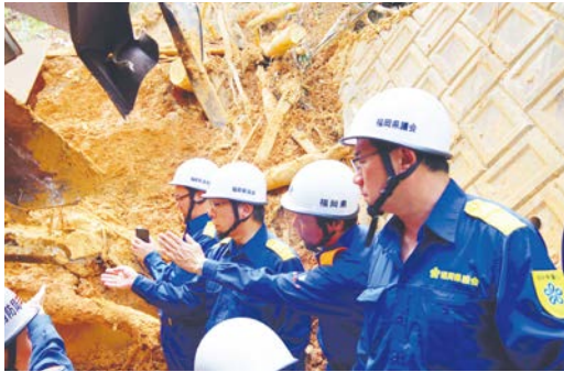
北九州市門司区の災害現場の視察
