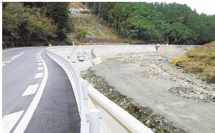
道路の改良復旧工事例
