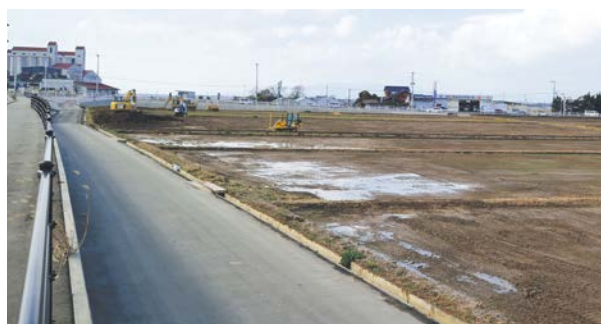
復旧が進む水田(朝倉市)
